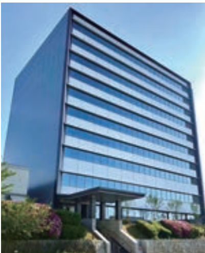
川崎重工業株式会社西神戸工場総合事務所(兵庫県)
