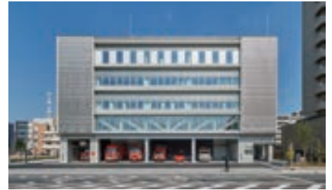
西宮市消防局西宮消防署(兵庫県)
