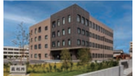
広島地方裁判所福山支部庁舎(広島県)
