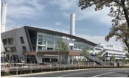
町田市バイオエネルギーセンター(東京都)
