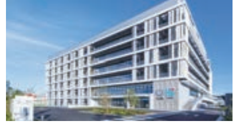
クリエイティブラボ神戸(兵庫県) 写真提供:神戸都市振興サービス㈱
